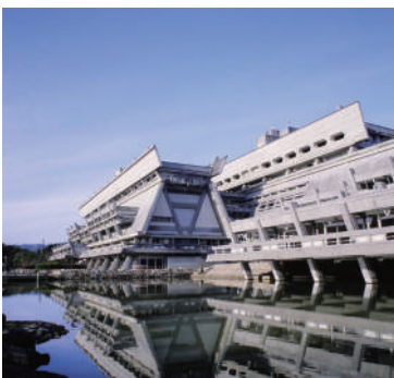
国立京都国際会館 画像提供：国立京都国際会館
